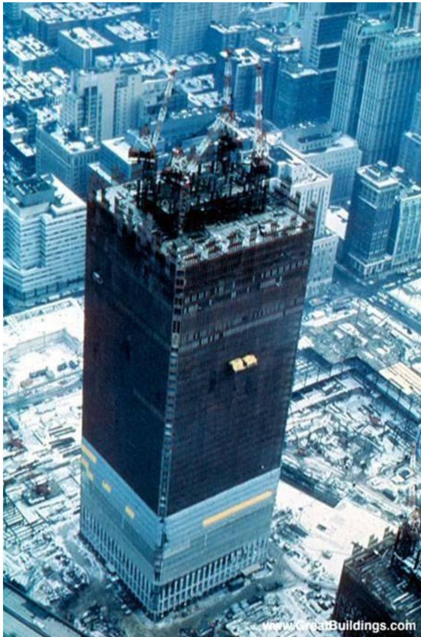
Las Torres del WTC fueron construidas robustamente con 47 columnas centrales de acero y otras 240 columnas de acero en el perímetro. Un total de 287 columnas de acero. Muchos dudan que incendios dispersos puedan haberlas hecho desplomarse sobre sí mismas (teoría oficial), y se sospecha el uso de explosivos.
