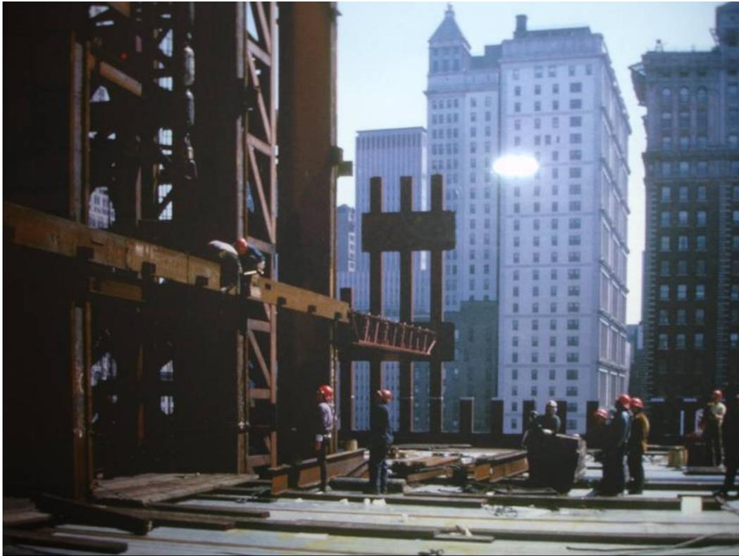
Estructura de acero: El gran núcleo central es un enorme sumidero de calor. Nótese los obreros de pie sobre las plataformas del suelo que están firmemente sujetas a las columnas centrales interconectadas.
