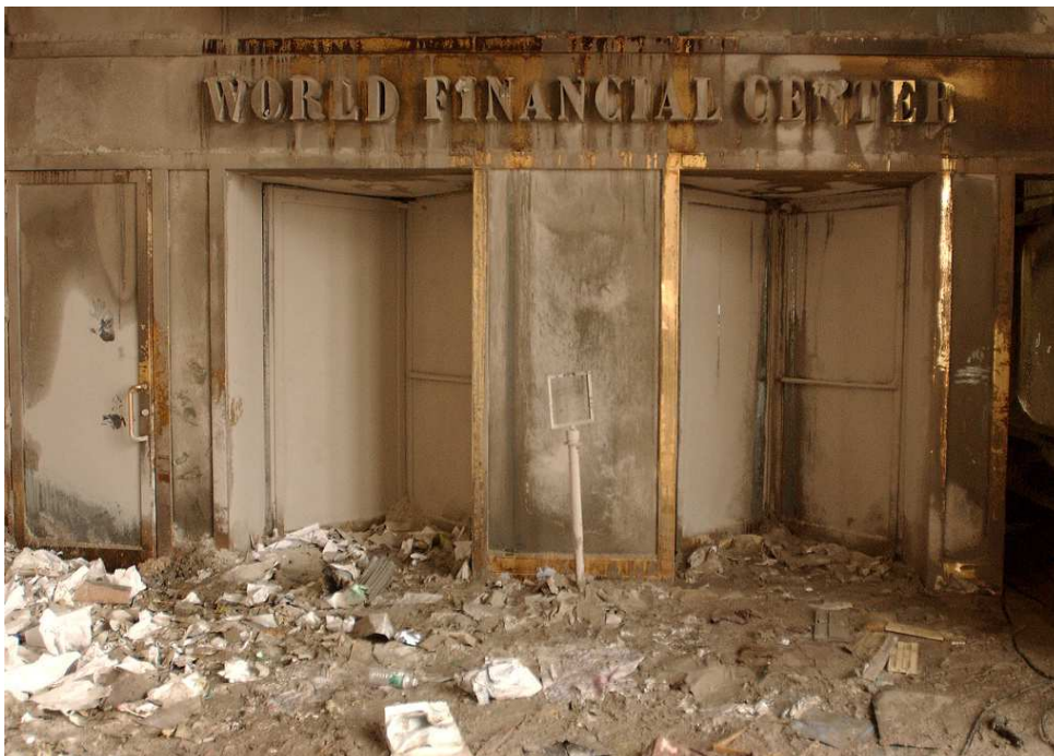
Rostfahnen am WTC-Eingang
